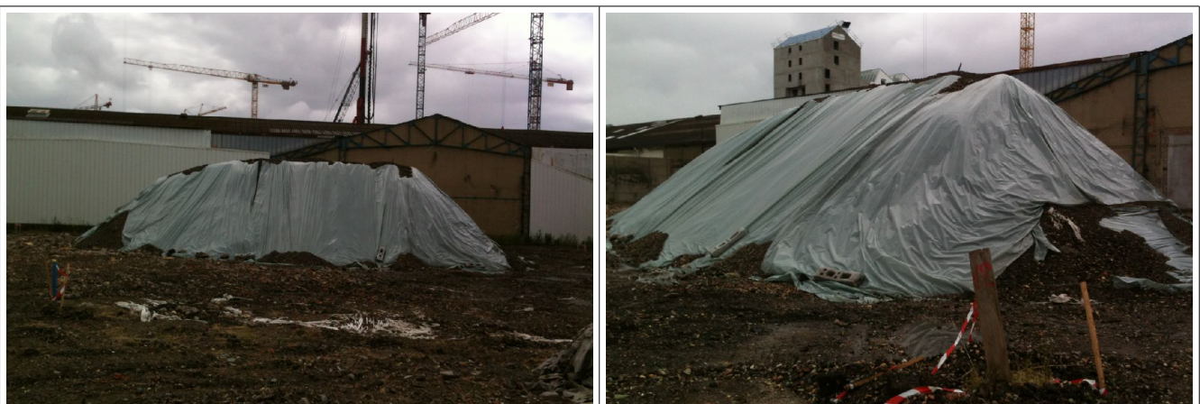
Vue sur le tas de déblais non inertes stockés au droit du site SREE Déblais issus du terrassement de la VNB3
